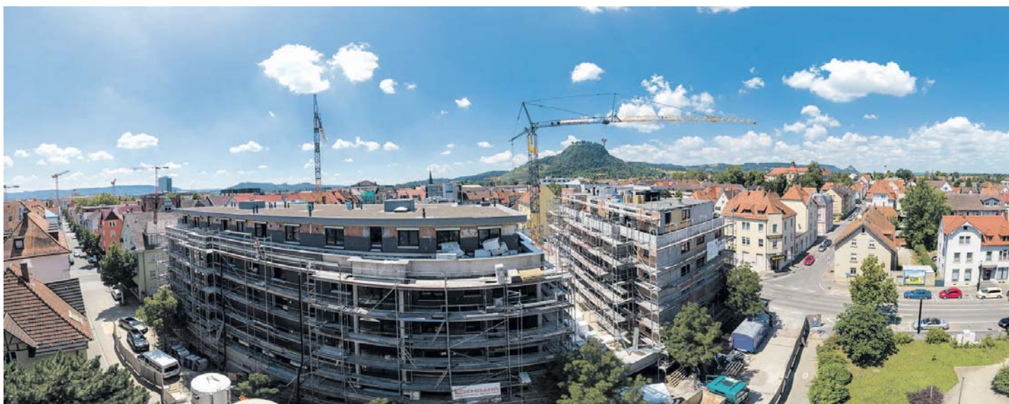
Die sieben Freikörperbauten wachsen auf dem Kunsthallenareal stetig in die Höhe. Foto von Juli 2019.
